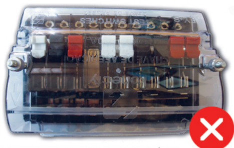
TAMPA POSICIONADA AO CONTRÁRIO.
